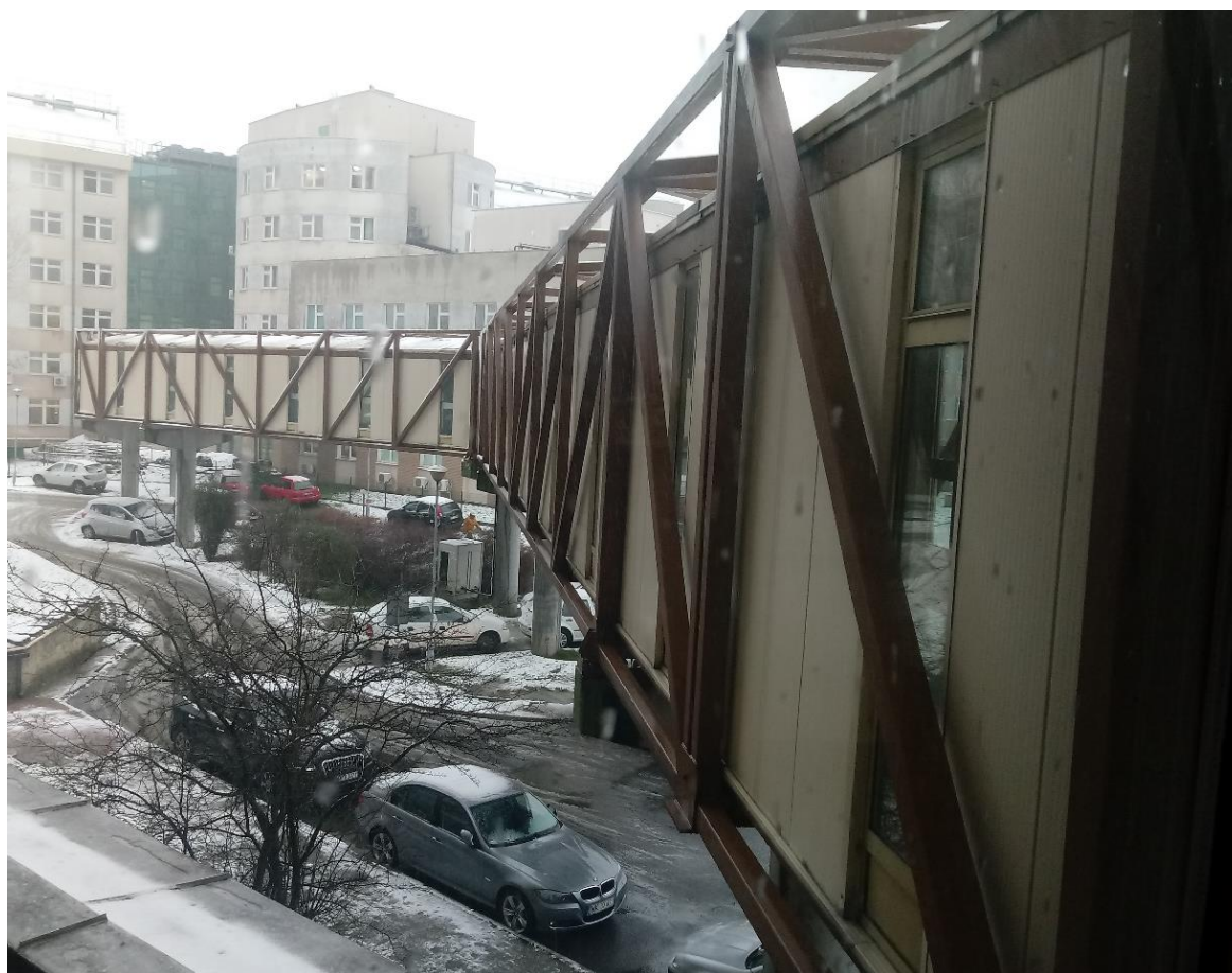
Zdjęcie nr 2- Widok łącznika od zewnątrz
